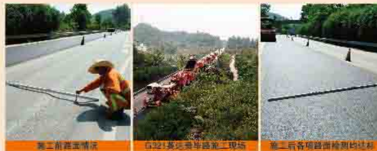
施工前路面情况
