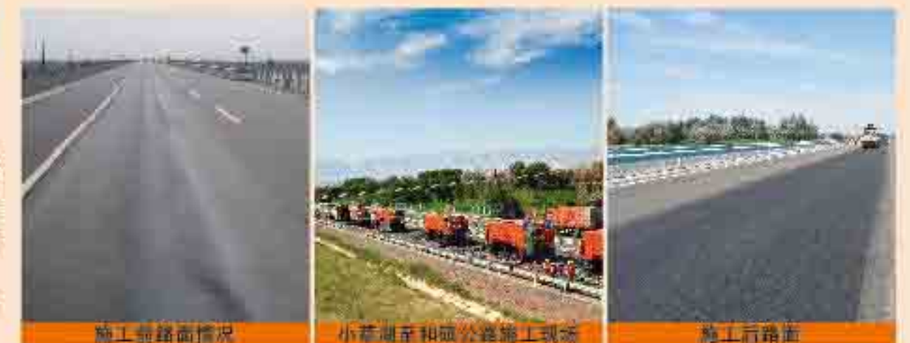
施工前路面情况
