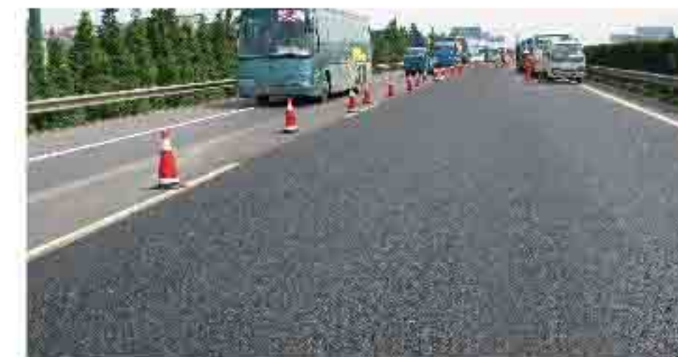
广佛肇高速英达施工后路面
