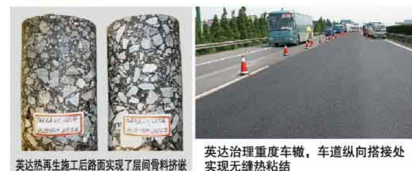
英达热再生施工后路面实现了层间骨料挤嵌 英达治理重度车辙，车道纵向搭接处实现无缝热粘结
