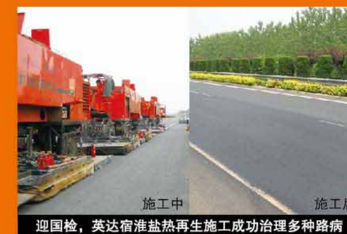
迎国检，英达宿淮盐热再生施工成功治理多种路病
