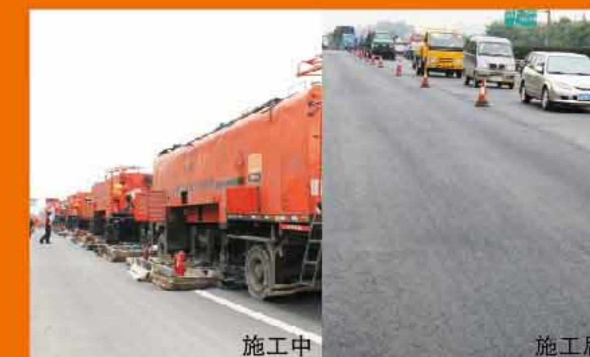
英达南京绕城公路热再生施工，确保国检不丢分
