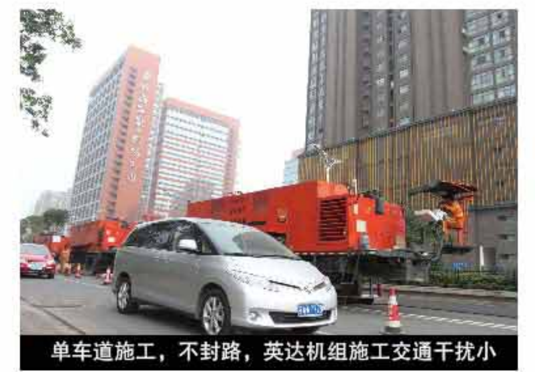
单车道施工，不封路，英达机组施工交通干扰小
