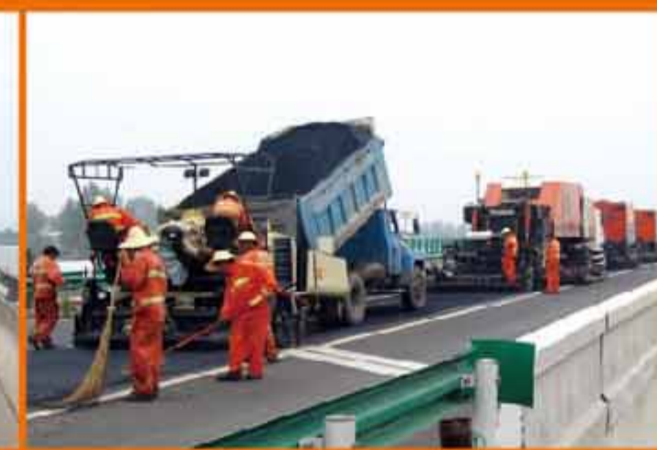
河南深平高速桥面施工
