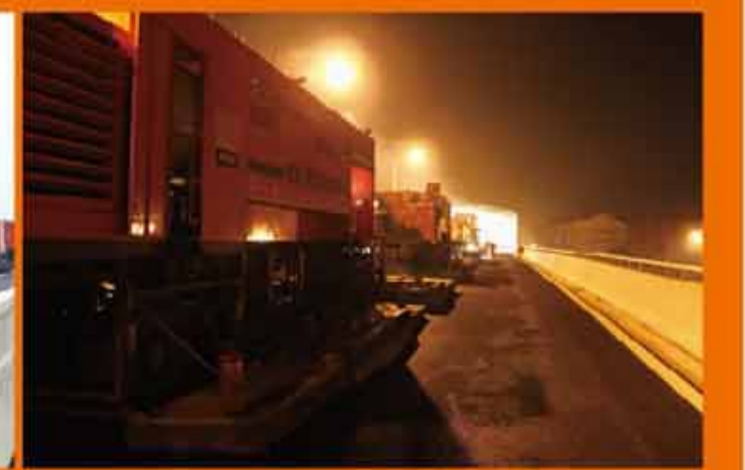
江苏南京纬七路高架桥桥面施工
