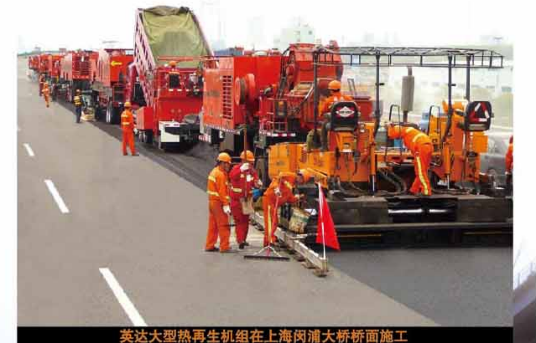
英达大型热再生机组在上海闵浦大桥桥面施工
