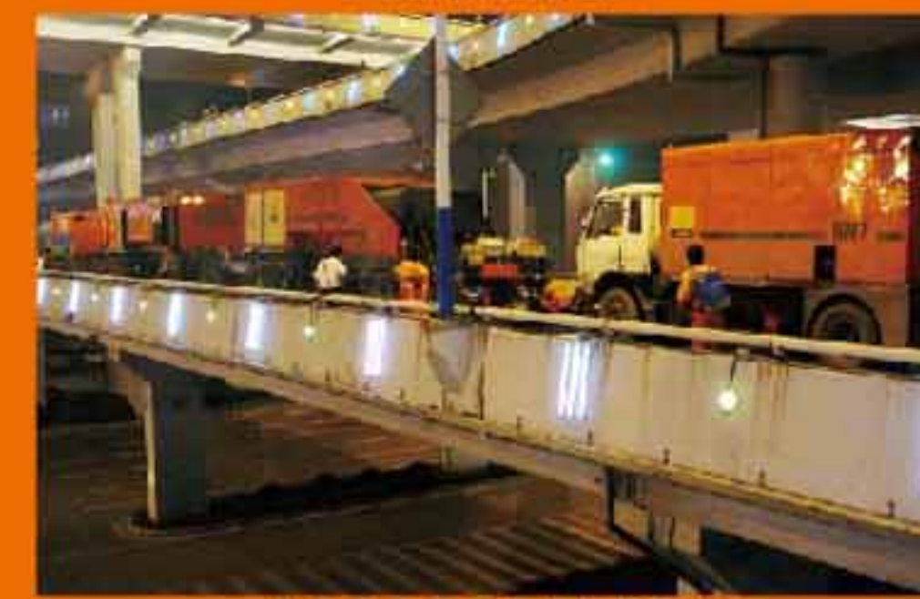
山东济南玉函立交桥桥面施工
