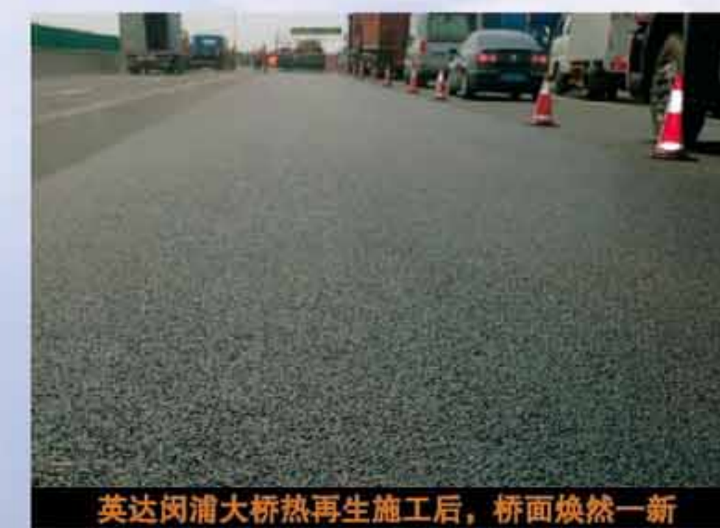
英达闵浦大桥热再生施工后,桥面焕然一新
