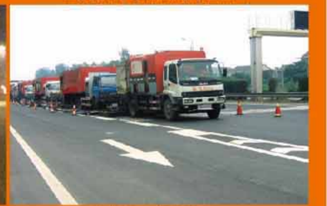
南京长江二桥桥面施工
