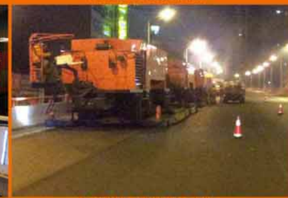
新疆创天高架桥桥面施工
