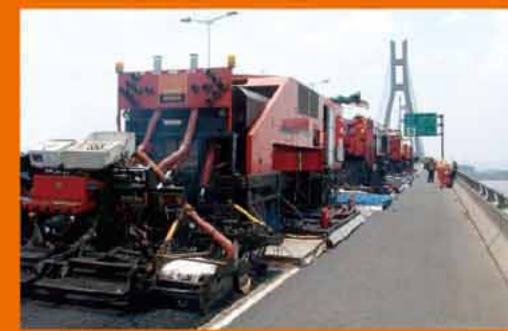
江苏润扬大桥施工
