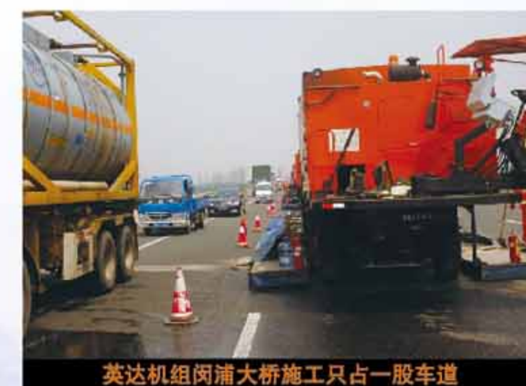
英达机组闵浦大桥施工只占一股车道
