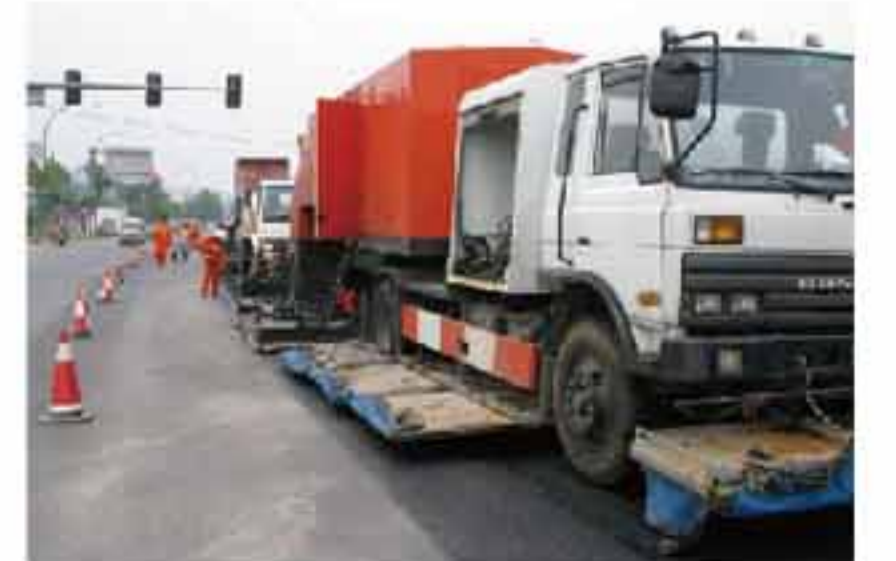
英达玄武大道施工环保、高效，施工5年后更显现质量优异
