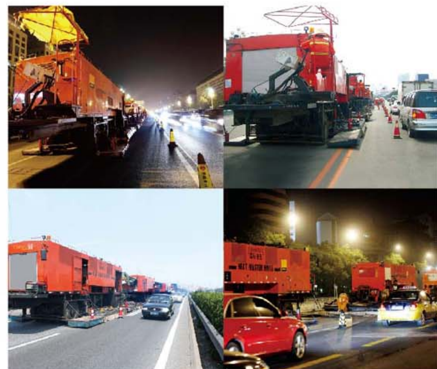
英达机组施工中只占据一股车道,交通干扰小
