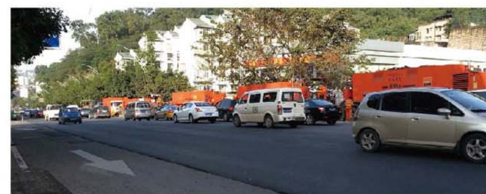
四川泸州英达热再生施工,转场速度与普通汽车一样
