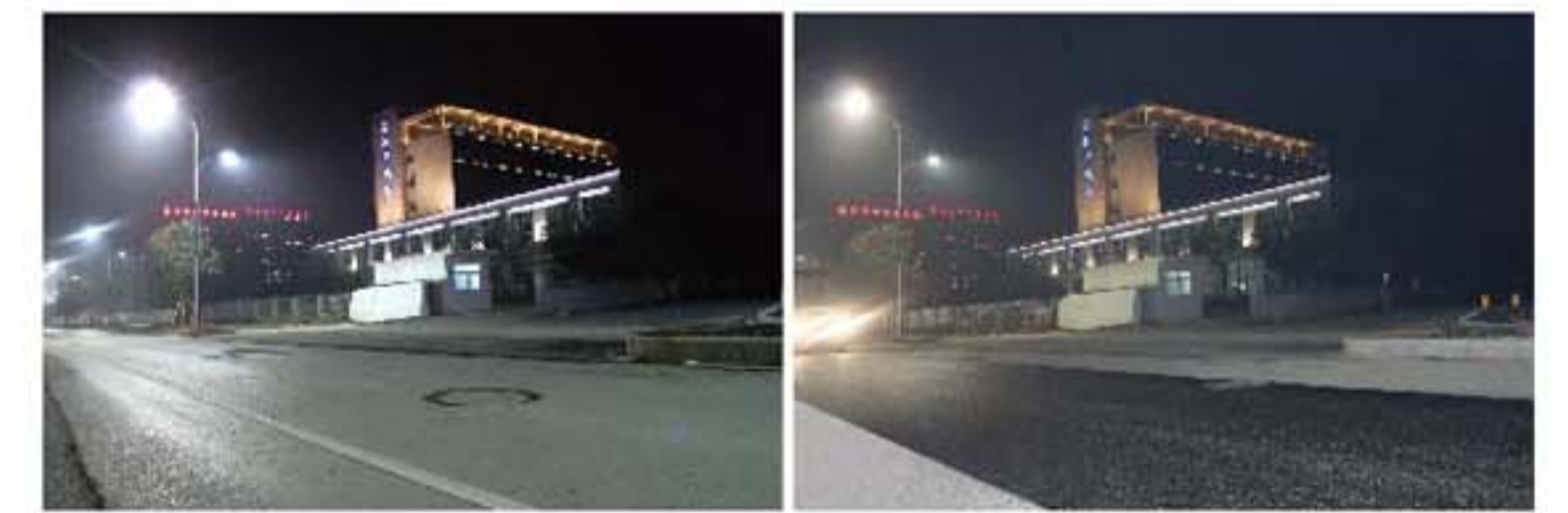
施工前后路面对比：治愈坑槽，路面焕然一新
