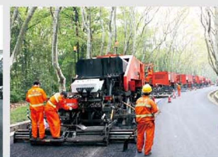
南京中山陵景区弯道、窄道施工
