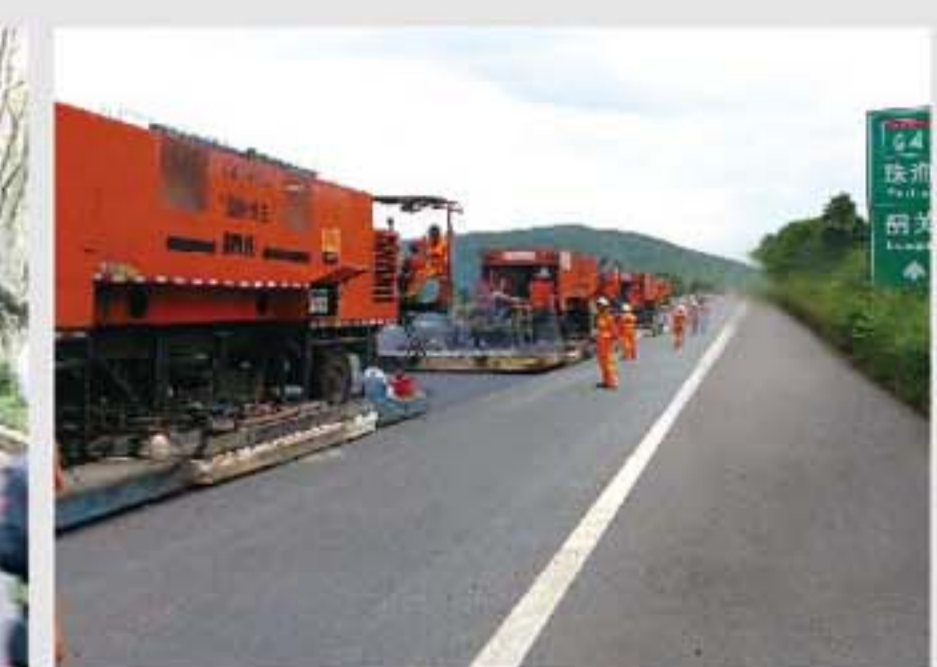
湖南来宜高速薄层罩面的热再生施工
