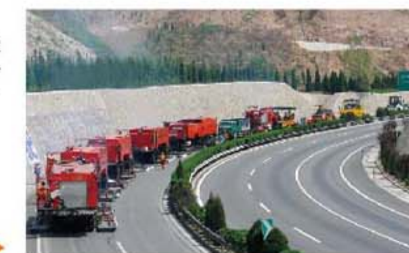
英达机组运三高速施工,克服弯道、大风、高海拔施工难题
