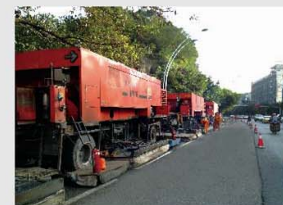
四川泸州弯道、坡道施工
