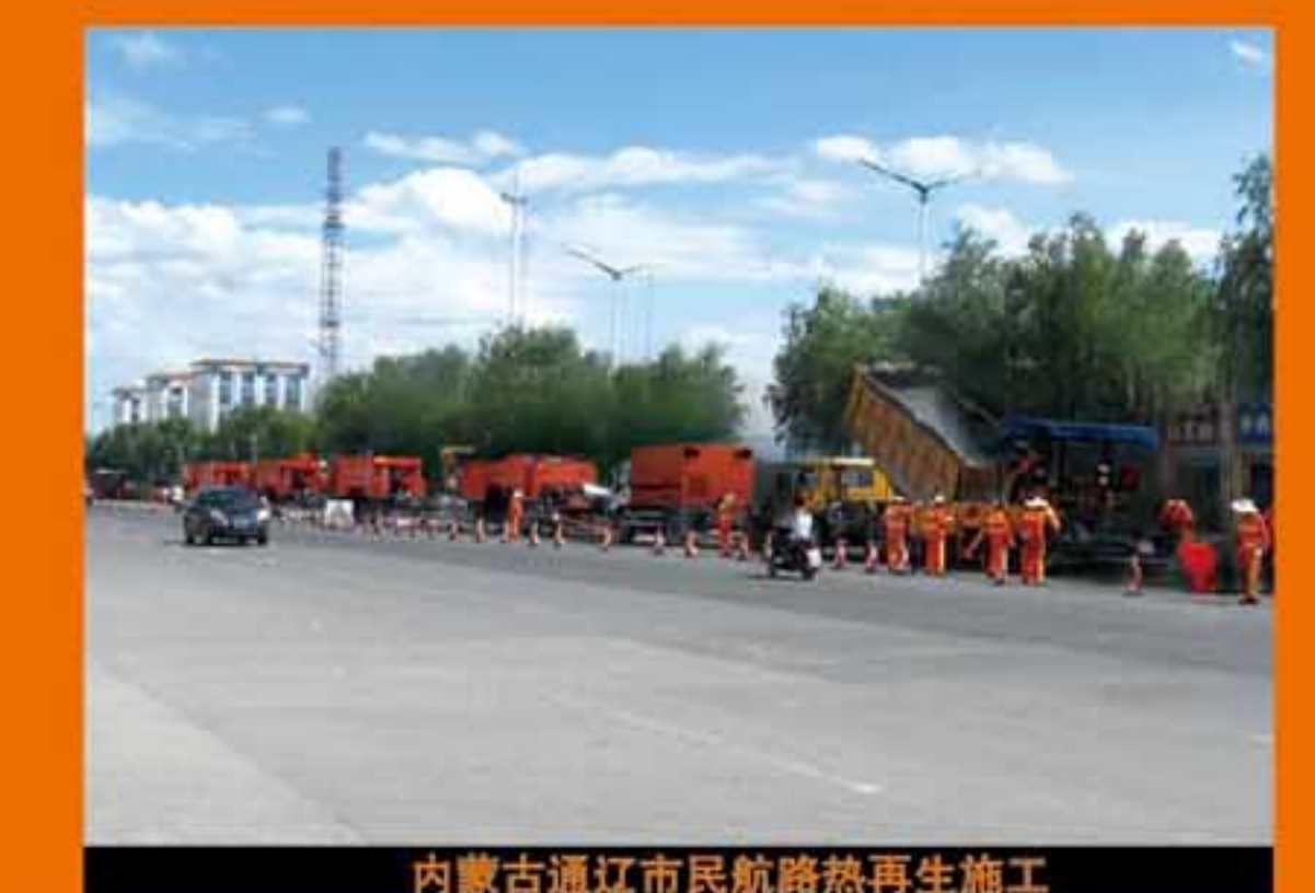
内蒙古通辽市民航路热再生施工
