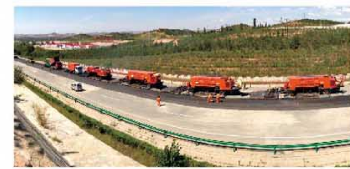
内蒙古鄂尔多斯东康线改扩建采用再生罩面工艺节省45%材料
