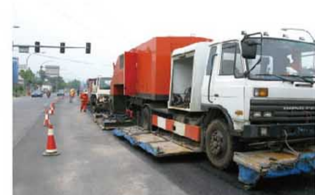
江苏南京玄武大道采用再生罩面工艺施工5年后路病害罕
