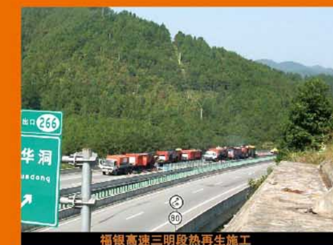
福银高速三期段热再生施工
