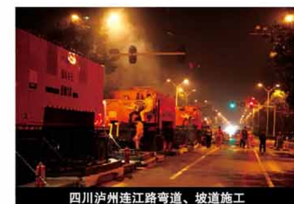
四川泸州连江路弯道、坡道施工
