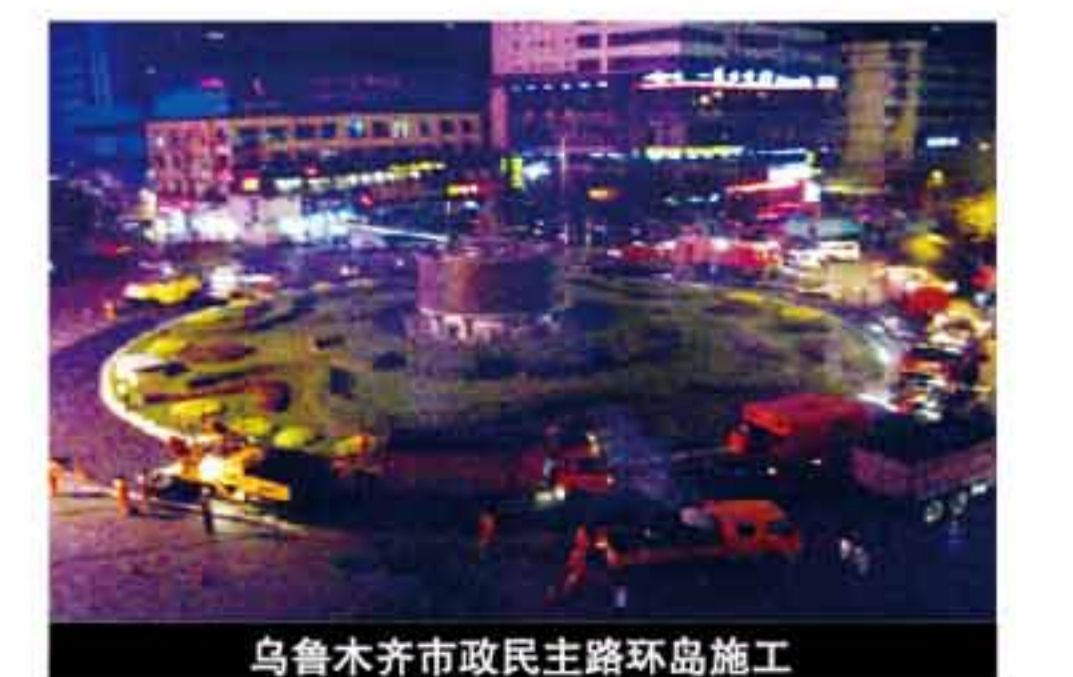
乌鲁木齐市民主路环岛施工
