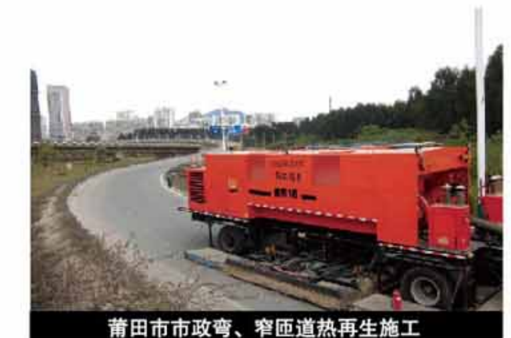
莆田市市政弯、窄匝道热再生施工
