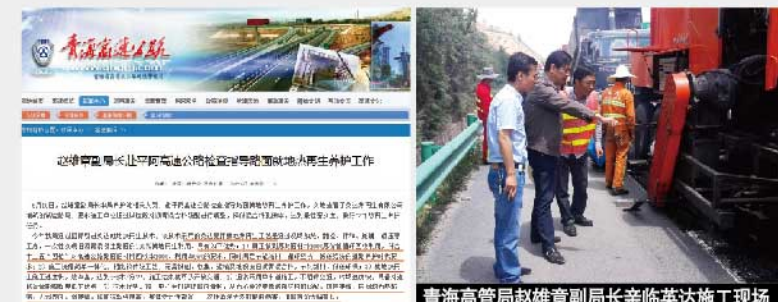
青海高管局赵维章副局长亲临英达施工现场
