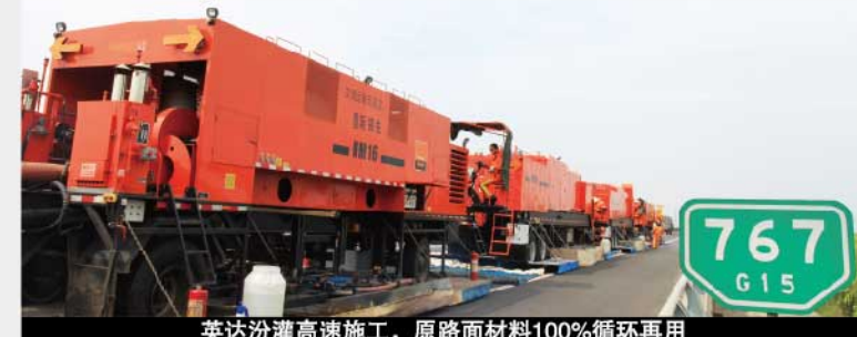
英达汾灌高速施工，原路面材料100%循环再用
