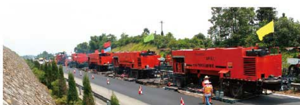
■ 2010年樟吉高速施工
