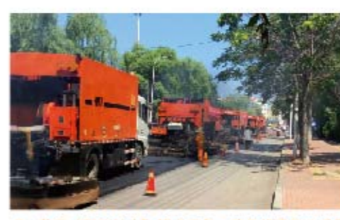
▲ 英达“国际领先”技术设备，确保优异施工质量
