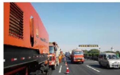
英达机组单车道施工，轻松应对苏嘉杭超大大车流
