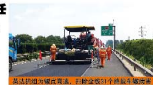
英达机组为锡宜高速，扫除全线31个标段车辙病害。
