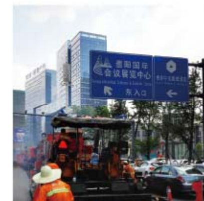
▲ 英达“橙色钢铁部队”在国际论坛主会场前施工现场
