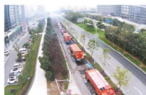
▲ 无扬尘、低噪音，宁波江南路修复后路面如同新建
