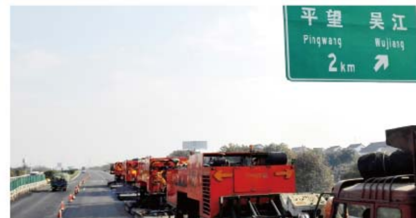
▲ 英达机组施工，原路面材料100%原价值循环再用
