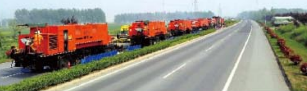
英达复拌机组为S250“调理体质”，原路面材料100%循环再用
