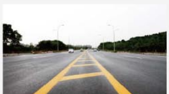
完工后的“海绵路”齐山大道首次检验：暴雨刚过却无积水，完美验证英达优质施工
