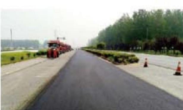
再生后路面平整度标准差σ仅0.75mm，远超高速公路要求标准 (<1.2mm)
