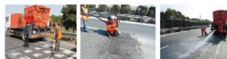
英达TM330,首创集路面冷补、补缝和清洗3大功能,解决一线工区难题
