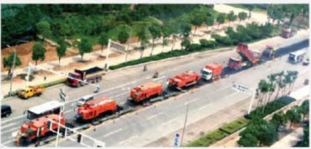
英达整形就地热再生机组仅用两周实际工作时间，让路面重展“新颜”
